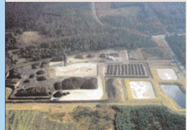
◀ Centre de compostage et de valorisation de matières résiduelles de GSI Environnement, Bury
